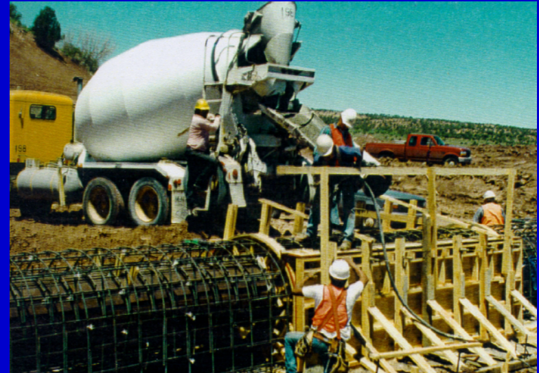
Construction of a new conduit
