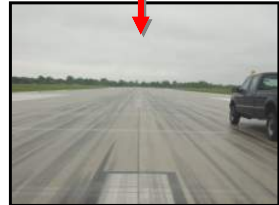
Selfridge ANG Base Rubblization Project
